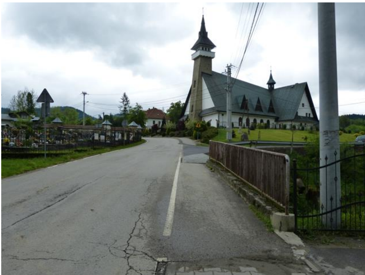
Fot. 11 Koniec odcinka w przysiółku Karczmisko – kościół.
