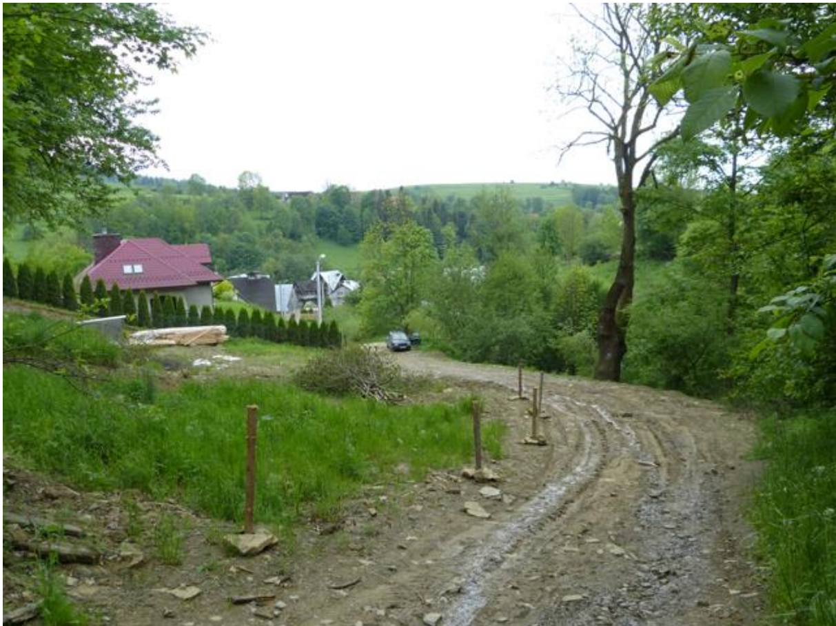
Fot. 24 Końcowy odcinek drogi w Rabce
