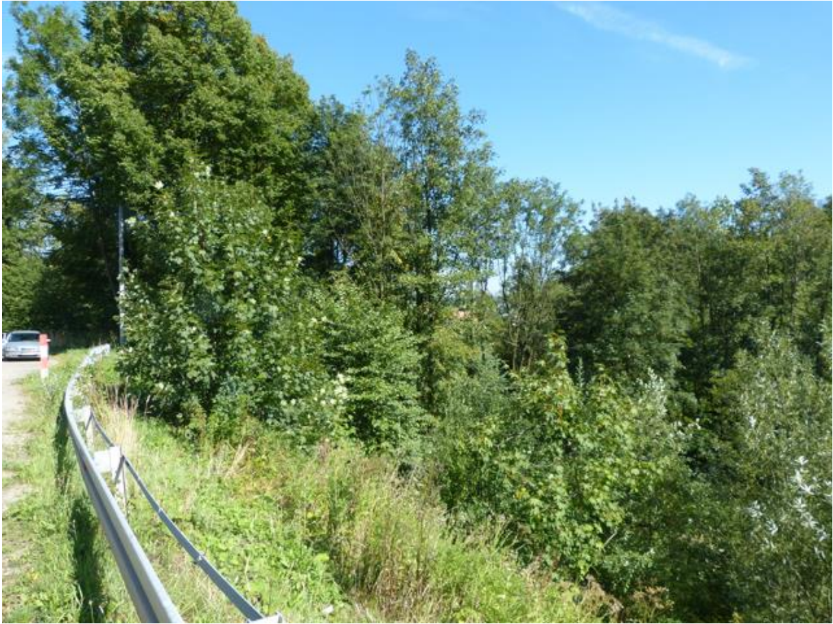
Fot. 26 Droga w miejscowości Olszówka
