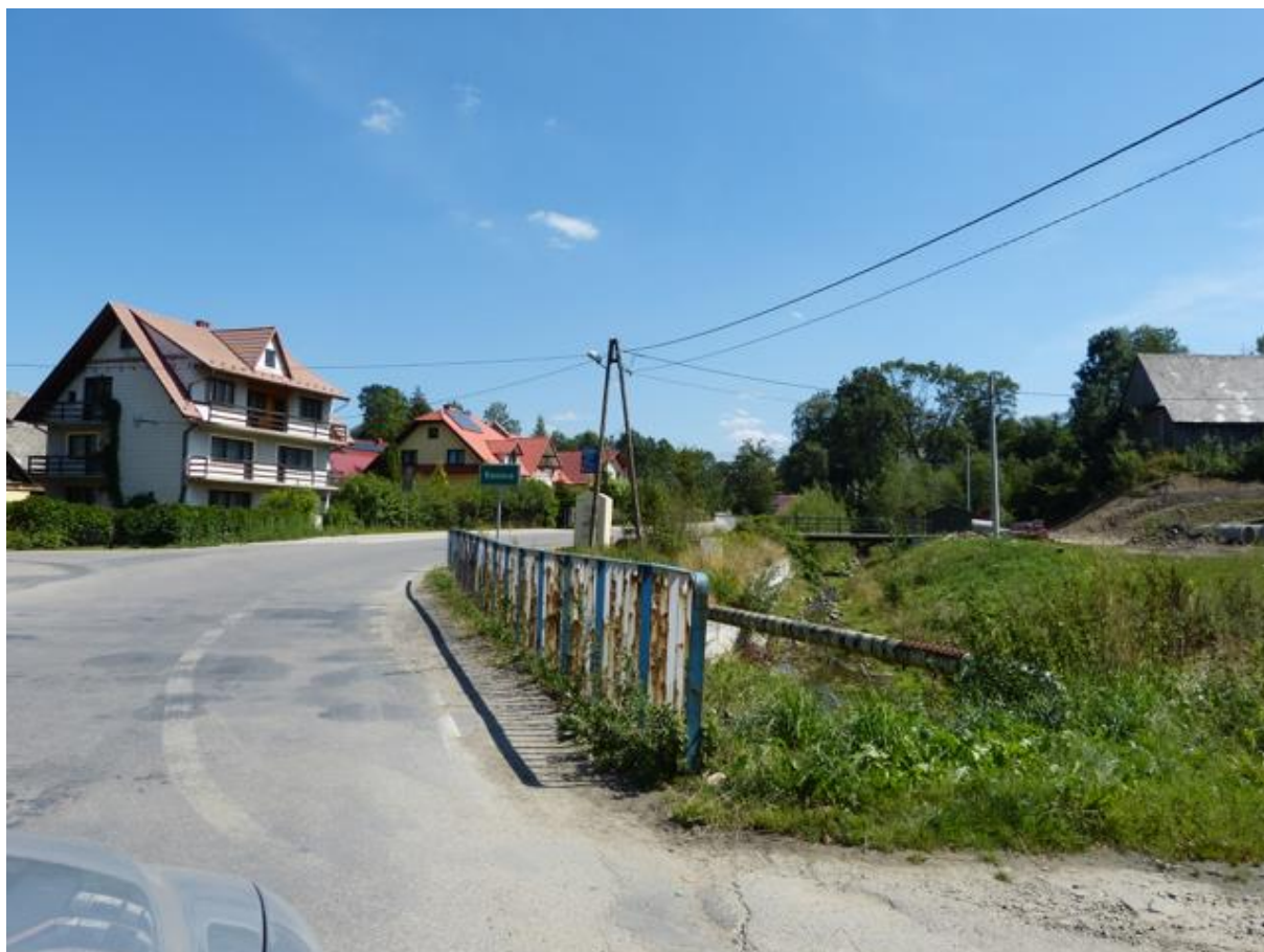
Fot. 42 Droga w miejscowości Niedźwiedź
