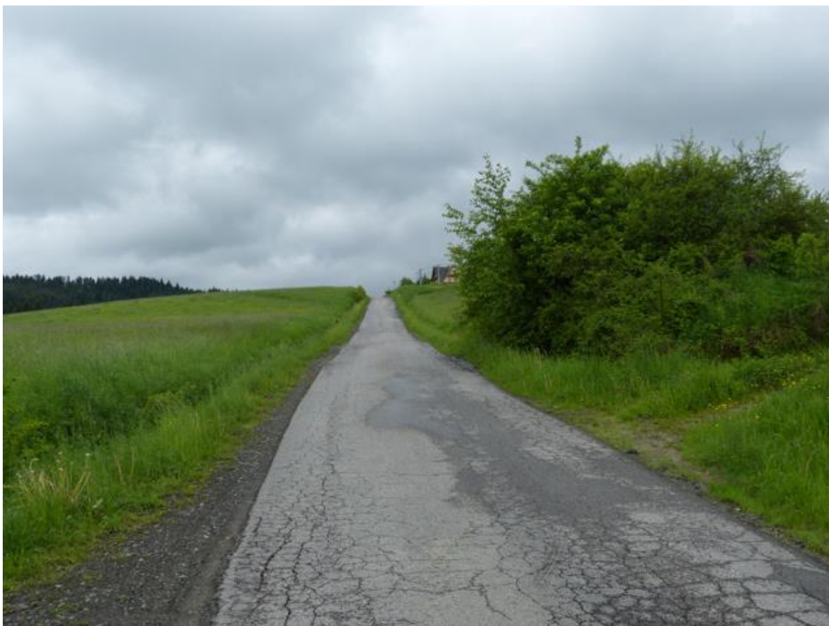
Fot. 13 Użytki rolne i zabudowania na początkowym odcinku drogi
