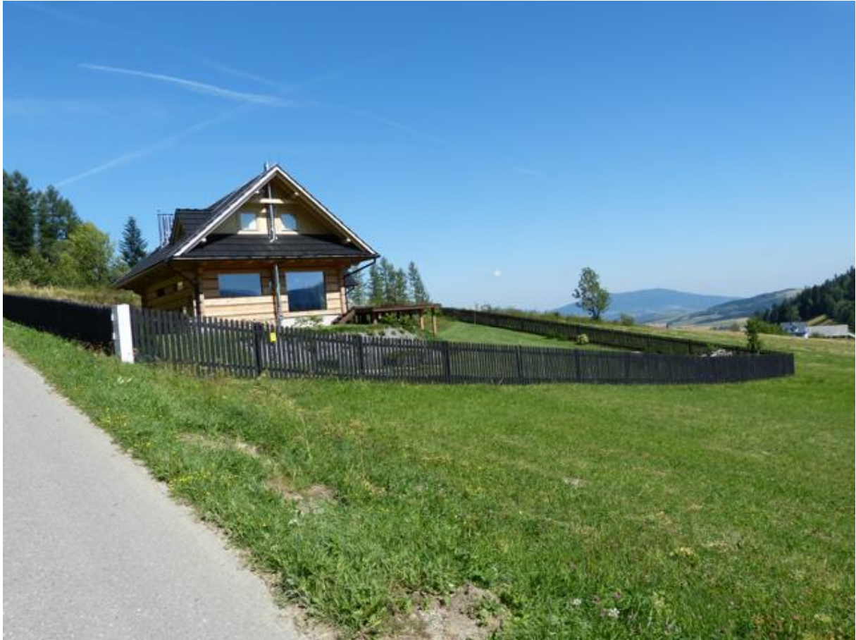
Fot. 33 Zabudowa rekreacyjna w przysiółku Chlipały
