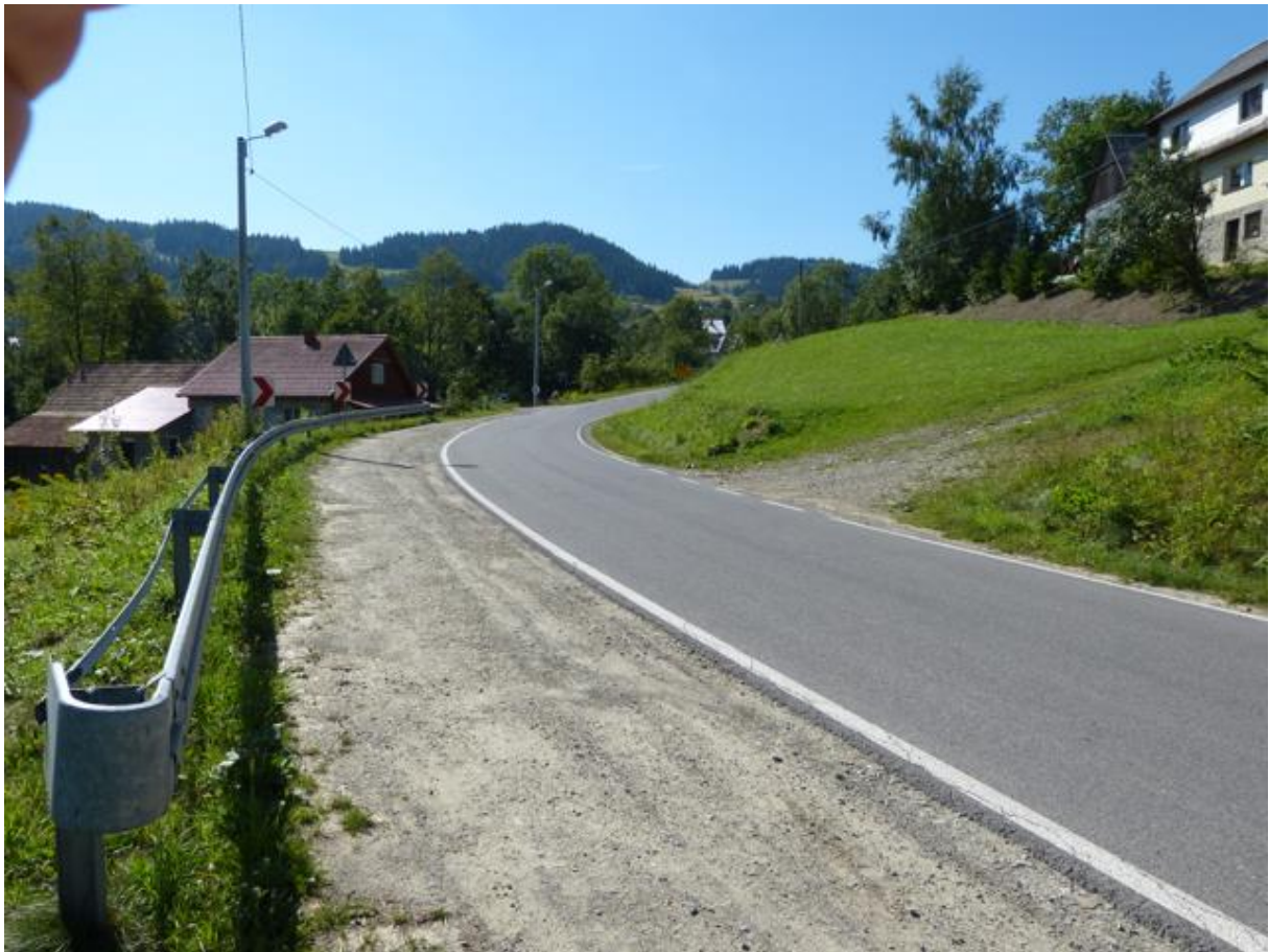
Fot. 27 Droga i zabudowa w miejscowości Olszówka cd.
