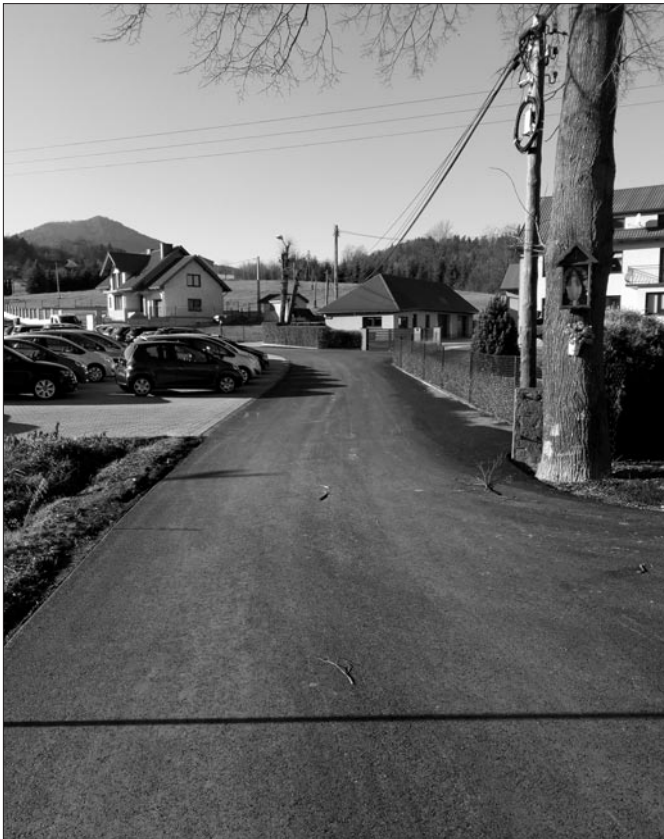
Wyremontowana droga na Budzyniu w Rabie Niżnej
