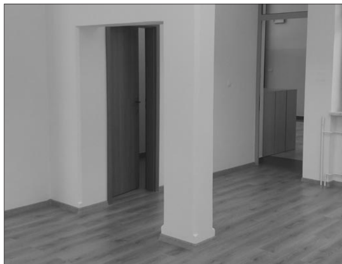
Adaptacja pomieszczenia na sale lekcyjne w SP w Łętowie
