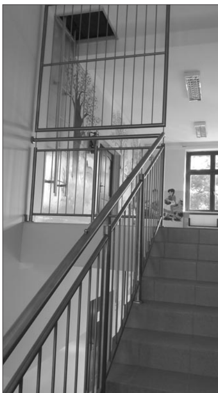
Remont klatki schodowej w ZPO Kasina Wielka
