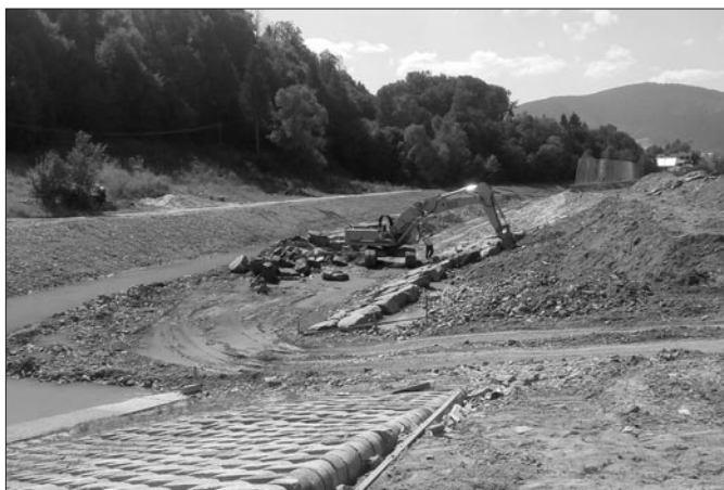
Zabezpieczenie brzegu potoku Kasinka od strony boisk ORLIK w Kasince Małej
