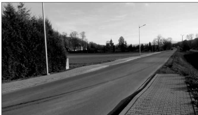
Chodnik przy drodze powiatowej w Kasince Małej
