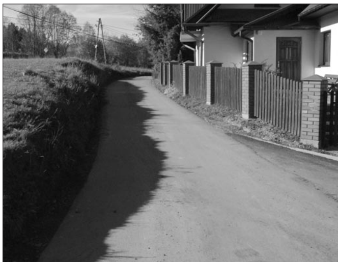
Droga na osiedlu Młyny w Lubomierzu
