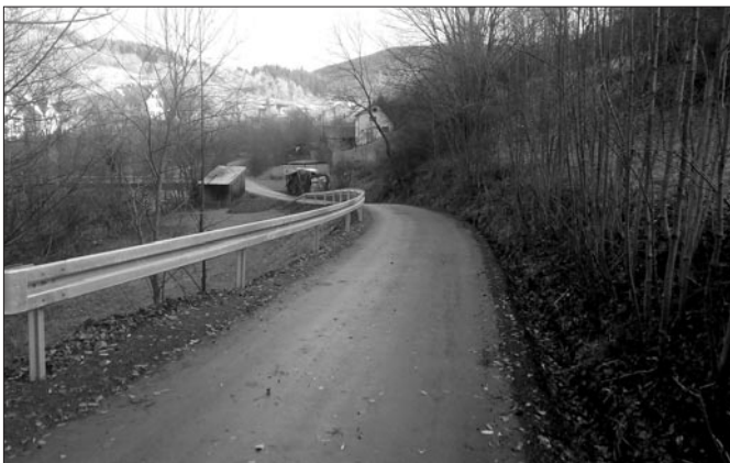
Droga na osiedlu Buloki w Łostówce
