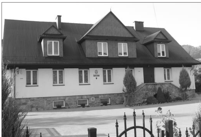
Remont dachu w Szkole nr 2 w Kasince Małej
