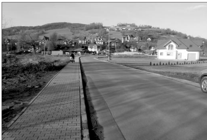
Chodnik przy drodze powiatowej w Kasince Małej
