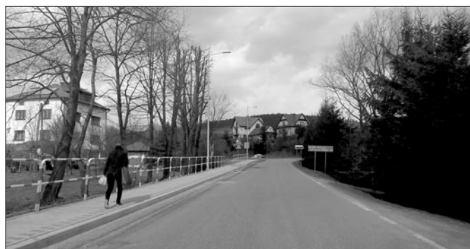
Chodnik przy drodze powiatowej w Kasinie Wielkiej
