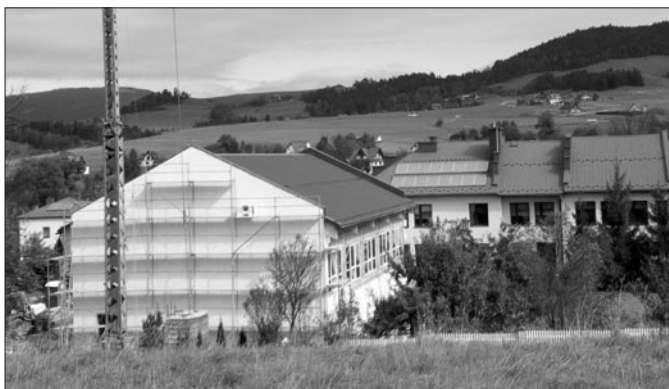
Budowa sali gimnastycznej przy szkole nr 2 w Mszanie Górnej
