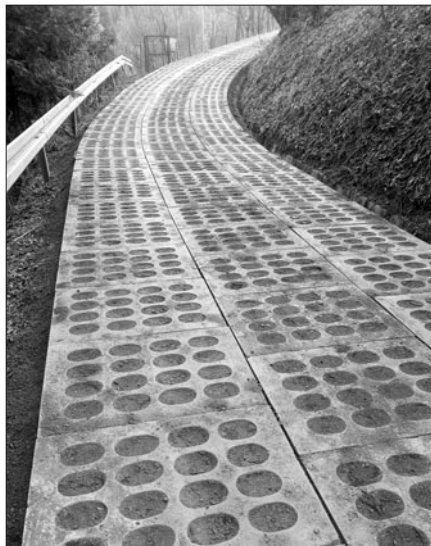
Wyremontowana droga na os. Żądły w Kasince Małej
