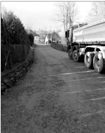
Remont drogi na os. Żury Łabuzy w Olszówce
